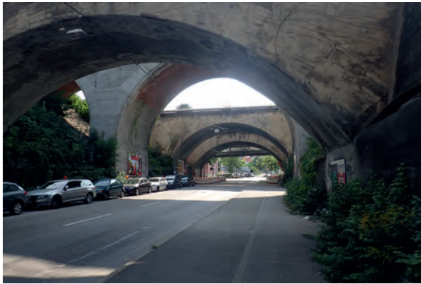
07 Unter den Stahlbetonbrücken an der Ehmmanstraße
