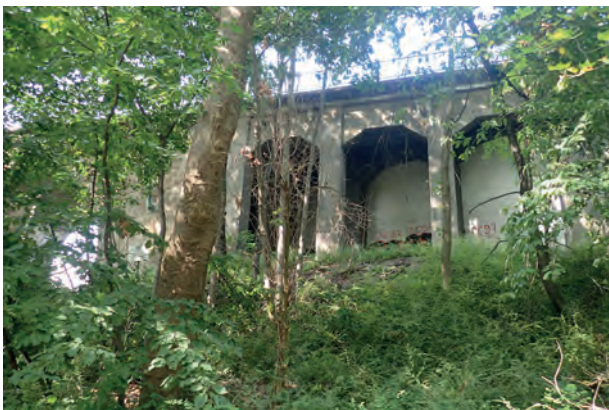
05 Das nördliche Überwerk von der Rosensteinstraße
