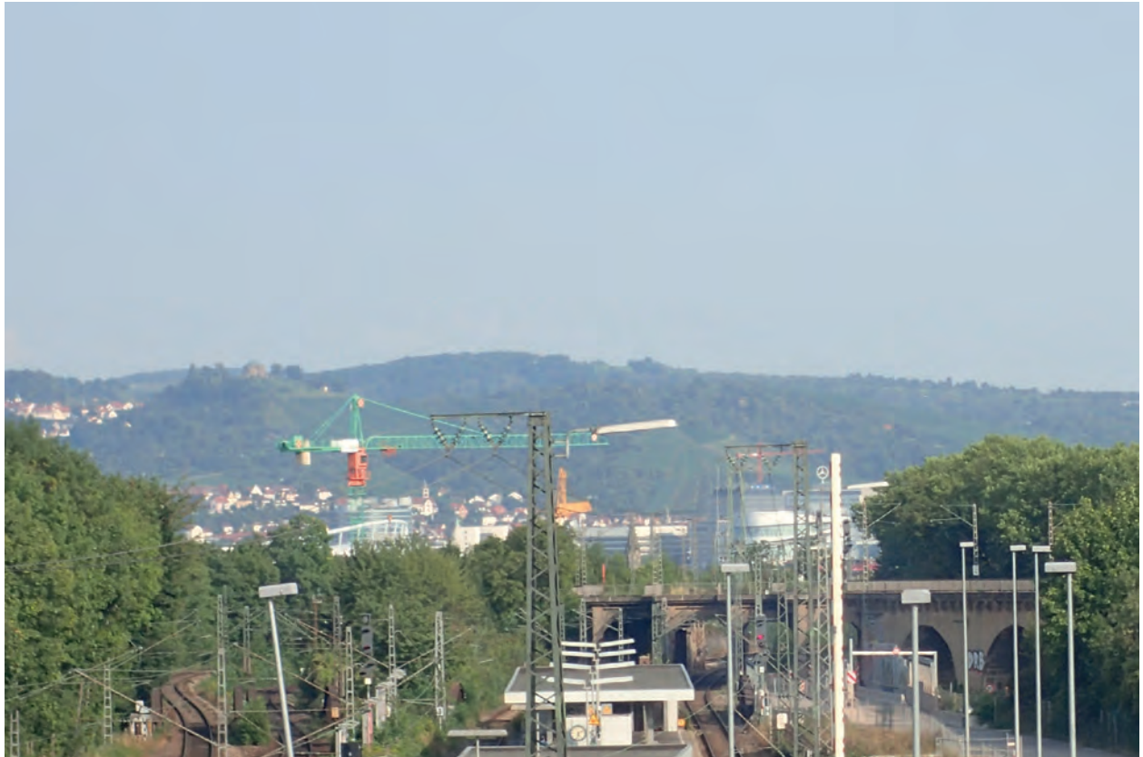
Blick vom Brünner Steg auf das Überwerfungsbauwerk. Im Hintergrund ist die Rotenbergkapelle zu sehen.
