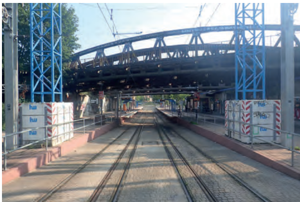
09 Stahlfachwerkbrücken über der Nordbahnhofstraße
